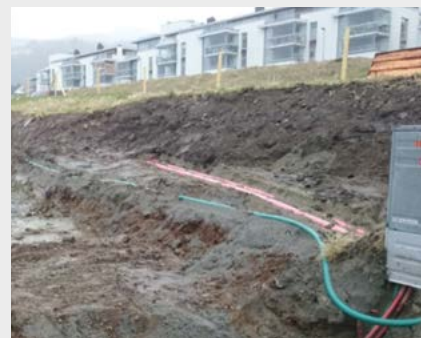
Fiber og El-grøft under omarbeiding i Aurefjora. Foto: Olav Martin Lid
