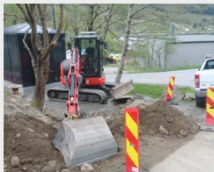
Node i Straumgjerde under etablering.
