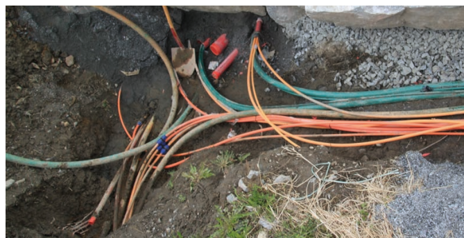
Eksempel på felles kabelgrøft med fiberrør. Foto: Jens Kåre Blakstad.
