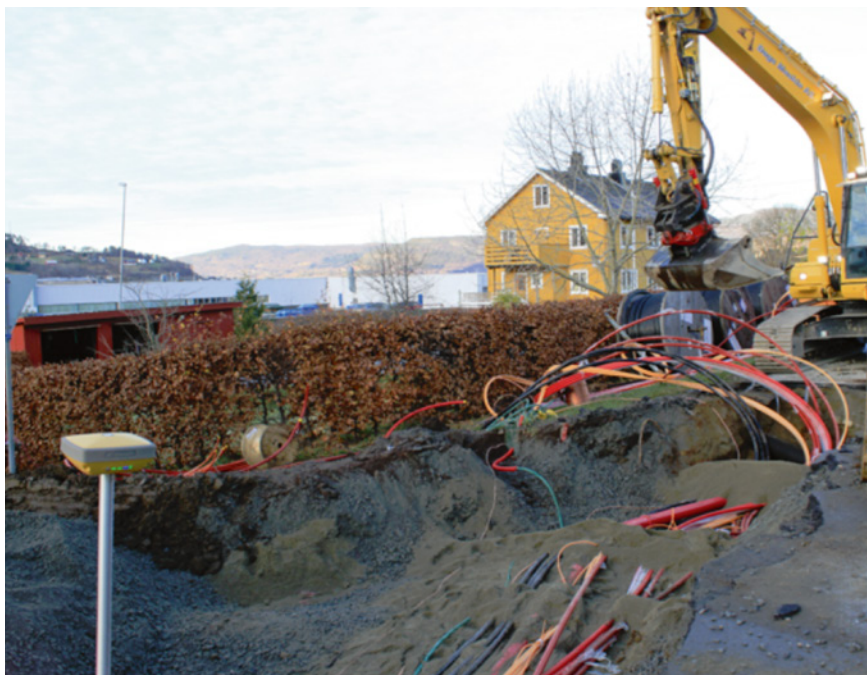
Bildet viser eksempel på nedgraving av fiberrøyr i felles trase med El og vatn.
