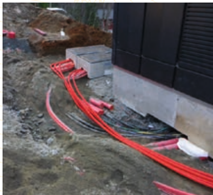
Bildet viser eksempel på nedgravne fiberør i felles trase med EI.
